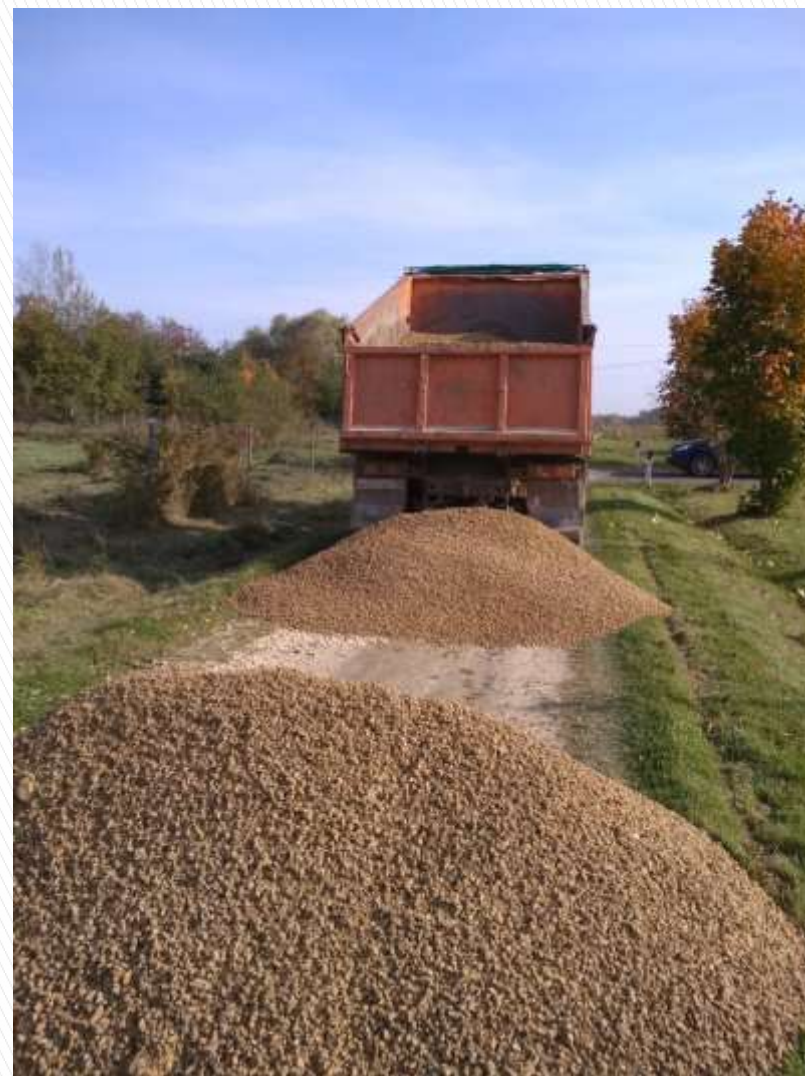
Отсыпка дороги в д. Коростелево
