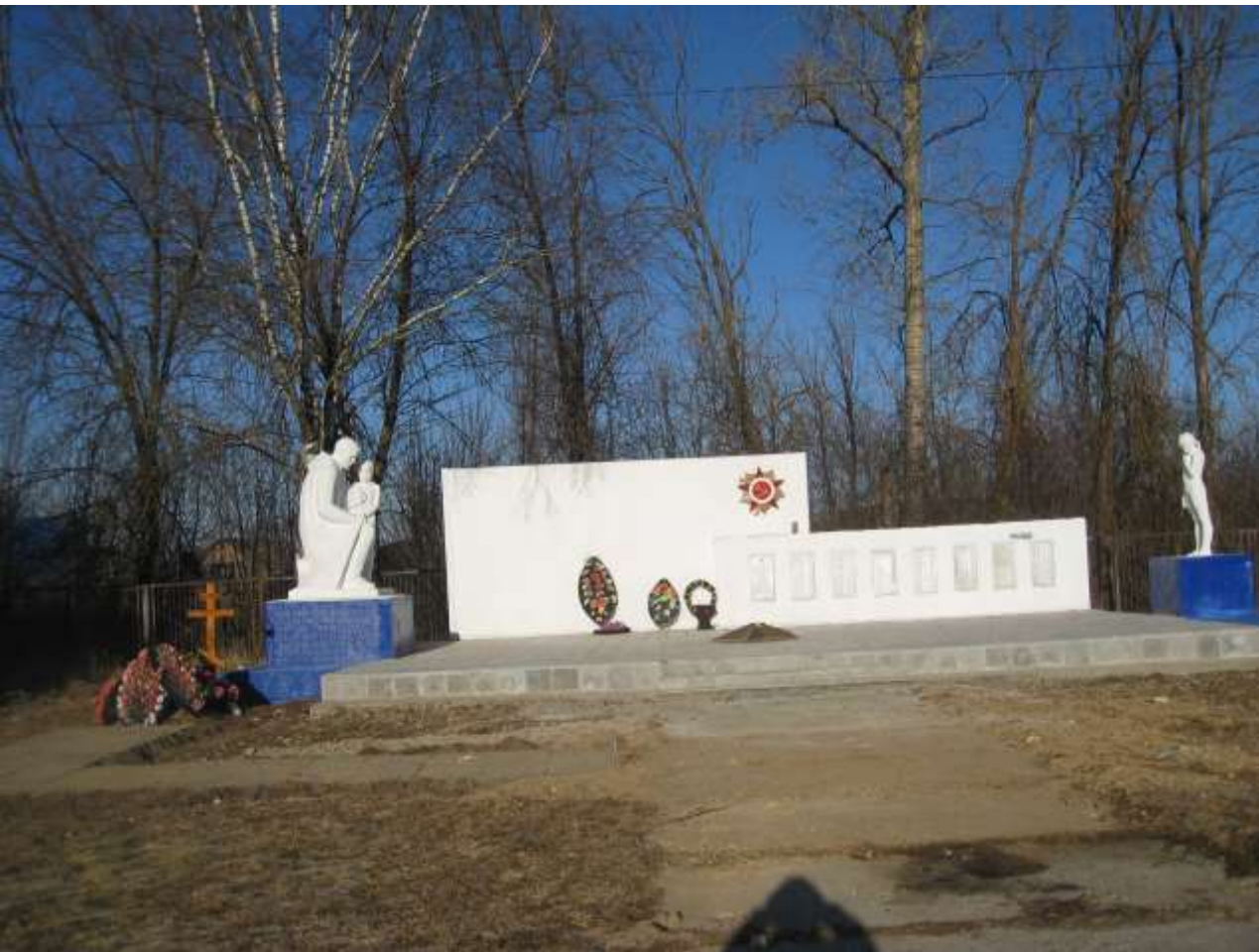
Внешний вид до ремонта
