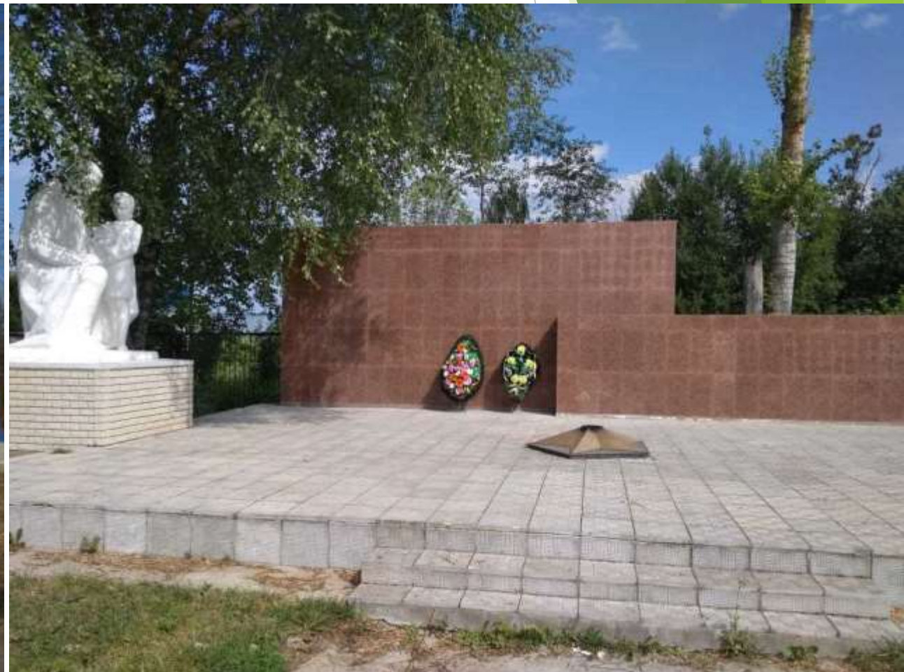
Братская могила после ремонта
